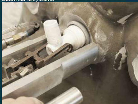
Vue du système de pose des buses par aspiration
